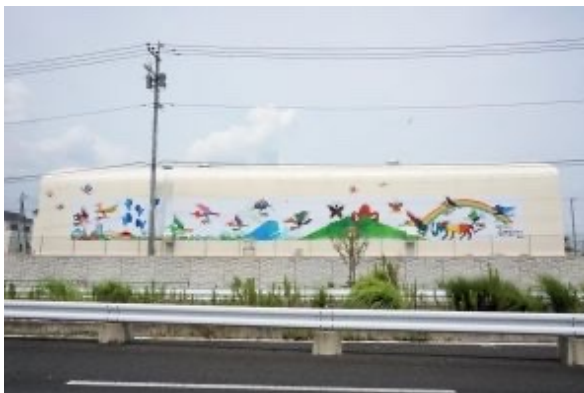
弊社テント倉庫の壁面にアートを 描いて頂きました
